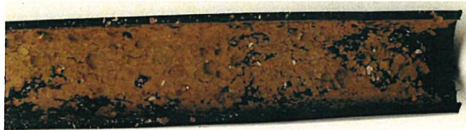
Vue en coupe d'un tube d'irrigation avant injection du Mexel® Irrigation.
